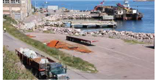
Les blocs rocheux de 3 à 6 tonnes ont été livrés en trois fois par barge et acheminés par camion jusqu'à la digue de l'Île-aux-Moules.
