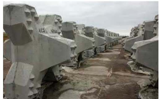
La forme particulière des accropodes leur permet de s'imbriquer solidement et de mieux absorber l'énergie de la houle.
