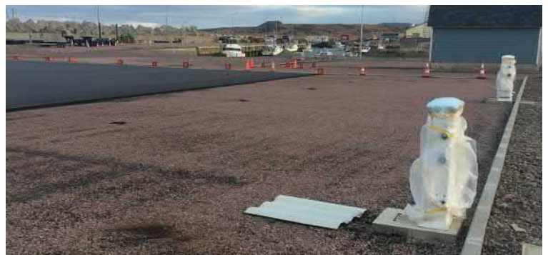
Vue du port à sec en cours de bitumage à la mi-novembre. Photo : C. Daguerre - Ingénierie des îles
