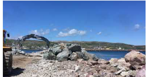
La mise en place des enrochements suit le gabarit mis en place sur le site.
