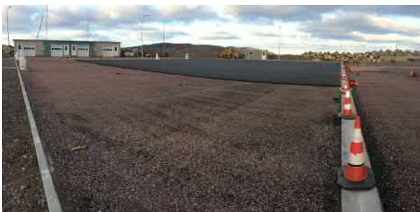
Vue de l'aire de carénage : 1600 m 2 équipés pour l'entretien ou l'entreposage des bateaux
